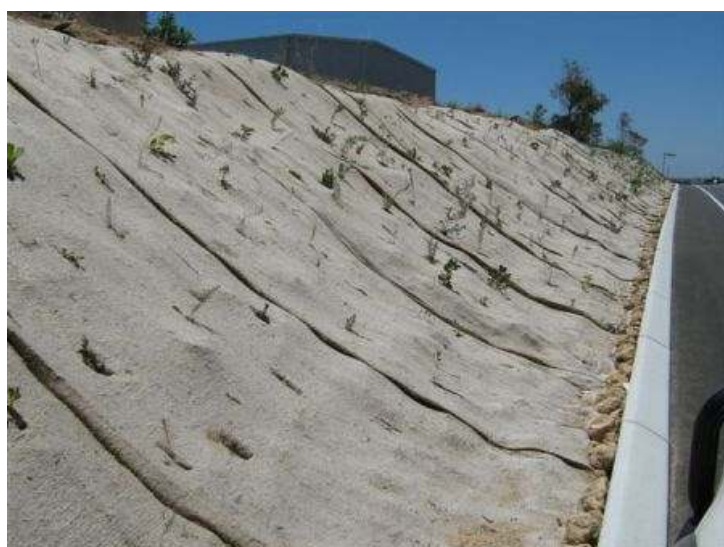
Jute mat slope stabilisation.
